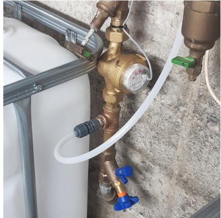
Beispiel eines Wasserzählers mit Impfstelle direkt neben dem Wirkstofftank.
