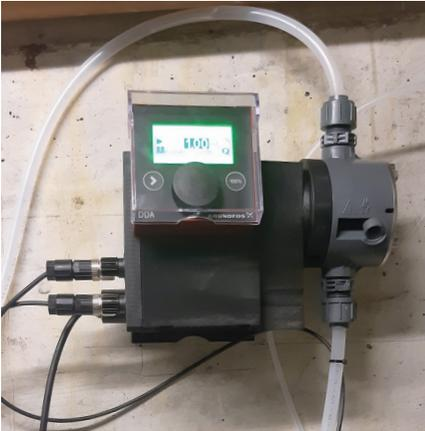
Auf diesem Bild ist die fixe Montage einer Dosierpumpe in der Nähe der Impfstelle ersichtlich. Die Auslegung erfolgt je nach Kundenanforderung.
